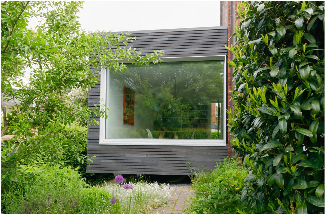
Für eine junge Familie wird die Doppelhaushälfte aus den 1930er-Jahren um einen kubischen, eingeschossigen Anbau in Holzrahmenbauweise ergänzt. Wenige, gezielt positionierte Fensteröffnungen in der mit vorpatinierten Holzprofilen verkleideten Fassade sorgen für helle Innenräume und spannende Blickbeziehungen zwischen Innen und Aussen.
