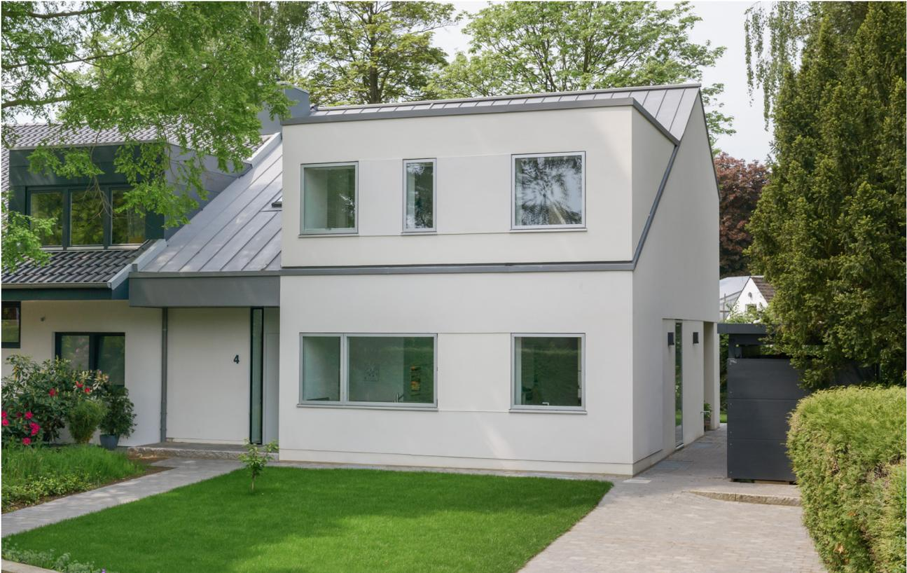
Um den räumlichen Bedürfnissen einer jungen, 5-köpfigen Familie gerecht zu werden, wurde die bestehende Doppelhaushälfte abgerissen und - entsprechend räumlich angepasst - wieder neu errichtet. Der in monolithischer Bauweise erstellte Putzbaukörper mit Metalldach, dessen Fassadenflächen durch verschiedenartig strukturierte Edelkratzputzoberflächen gegliedert sind, nimmt dabei die Kubatur der ursprünglichen Doppelhaushälfte auf und wird um eine große Gaube ergänzt.
